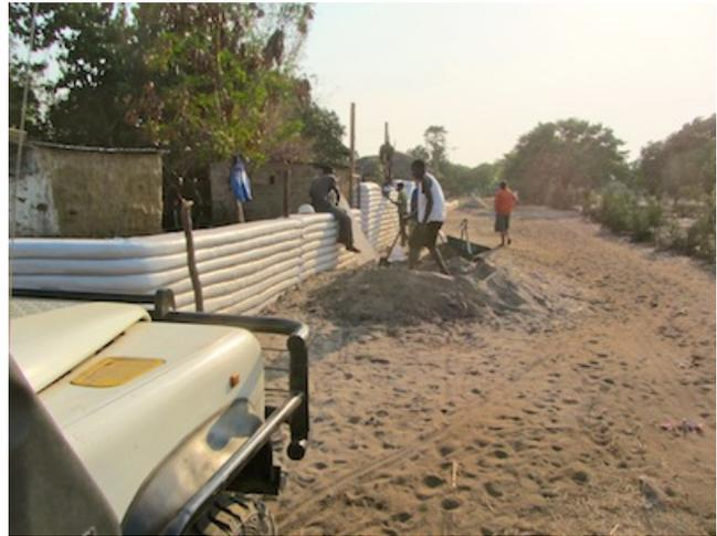
Der aufgebrauchte Zementputz, nach Anbringen von Hühnerdraht, dient in erster Linie dem Schutz des Sackmaterials, das durch UV-Licht zerstört würde. Zum Schluss haben wir, wie bei allen Liyoyelo Gebäuden, eine Schicht Naturpigment aufgetragen, das ganz in der Nähe zu finden ist.
